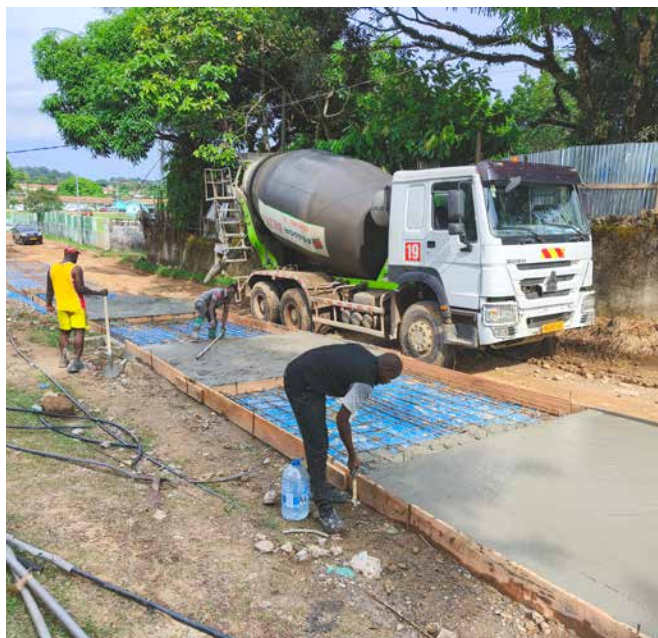
Budowa drogi dojazdowej do Sanktuarium.
