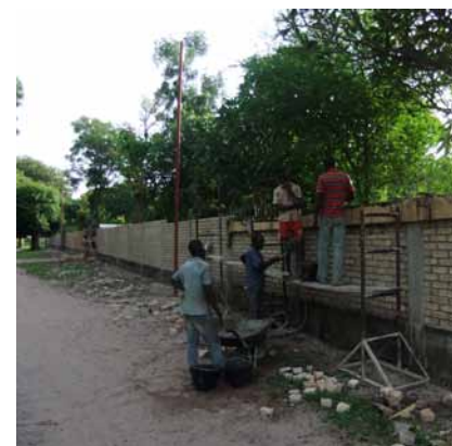
Nowy mur ogrodzeniowy
