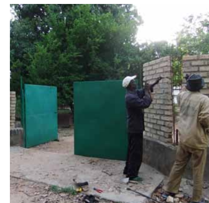
Nowa brama wjazdowa
