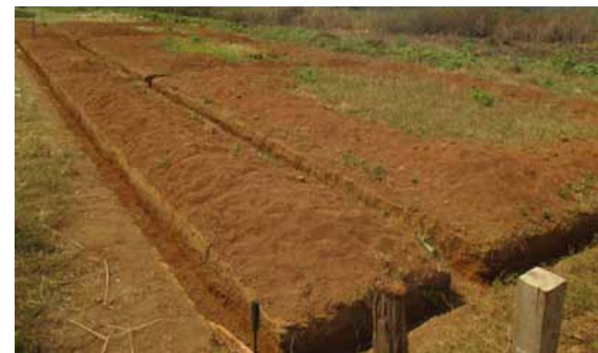
Wykopy pod fundamenty szkoły
